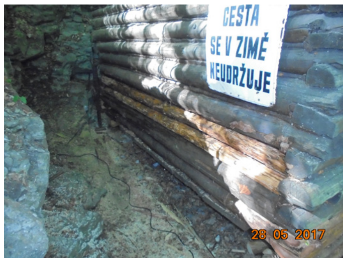
Terénní základna na Malé Base před a po opravě
